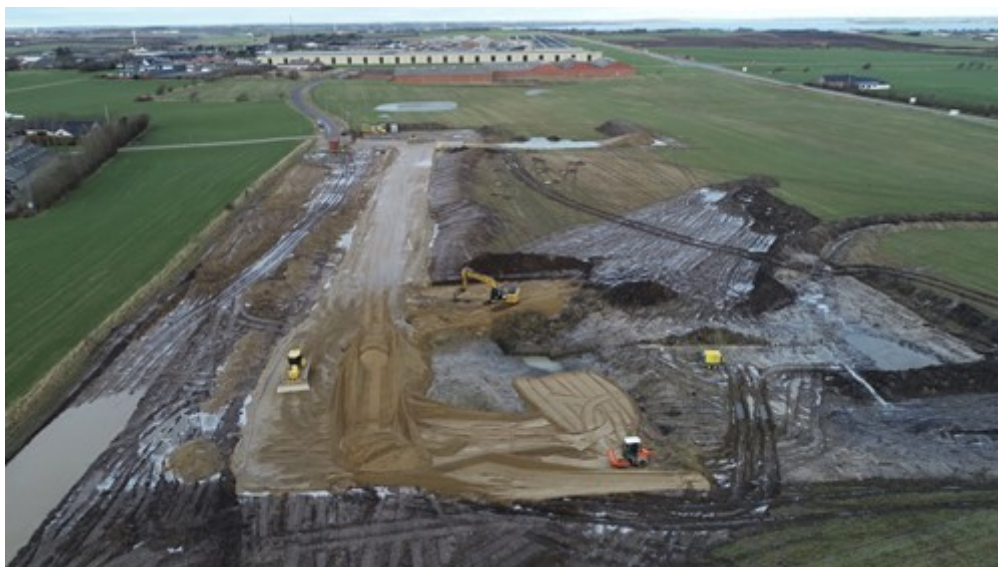
Dronefoto fra januar 2021. Etablering af det nye genbrugscenter på Slyngborgvej.
